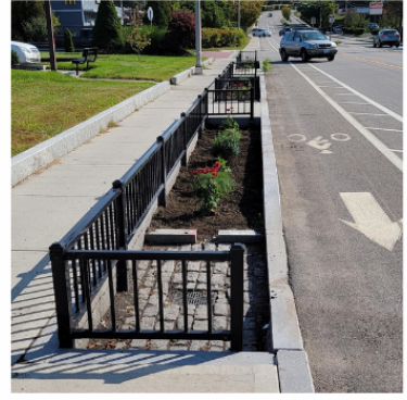
Reparación de bioswales en una carretera estatal en Wakefield
